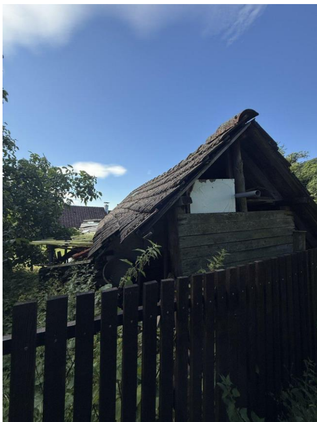
Objekt na pozemku parc.č. 107
