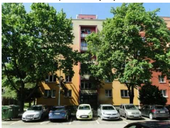
Uliční pohled na bytový dům
