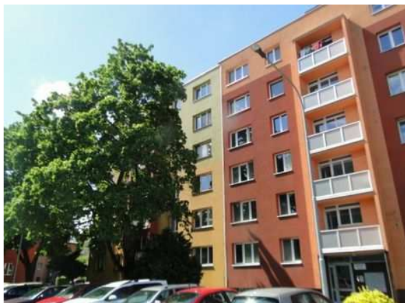
Uliční pohled na bytový dům
