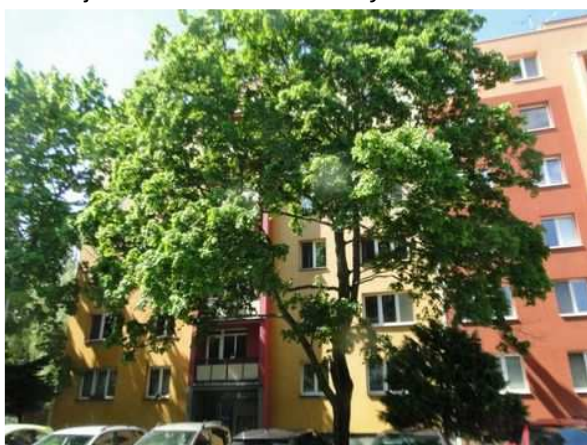
Uliční pohled na bytový dům
