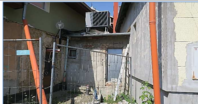
Objekt kotelna (na pozemku souseda)
