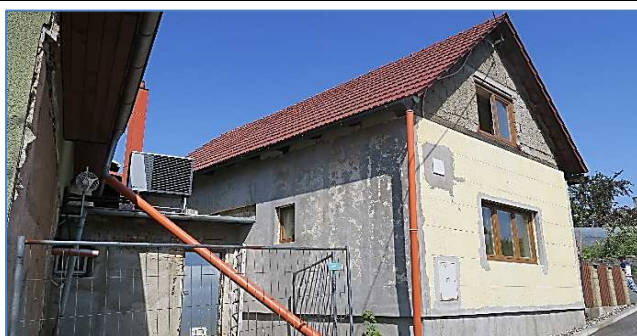
Dům č.p. 237 uliční průčelí
