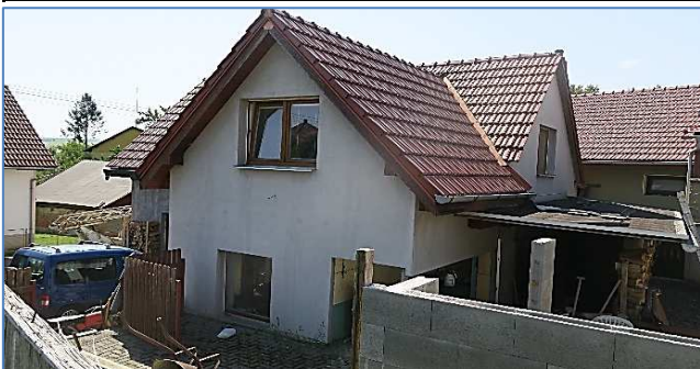
Dům č.p. 237 uliční průčelí severní
