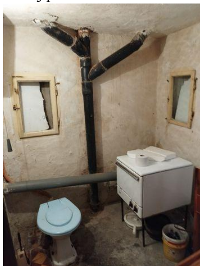
WC na chodbě u vstupu do sklepa
