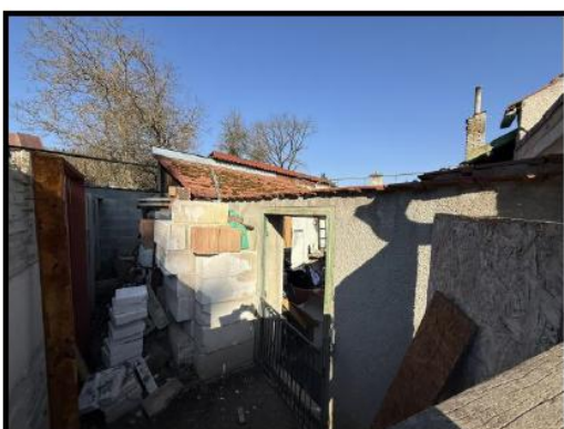
SNÍMEK Č. 5 – DVŮR ZA RD Č.P. 14, VEDLEJŠÍ STAVBY
