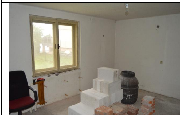
PŘÍZEMNÍ ČÁST V REKONSTRUKCI
