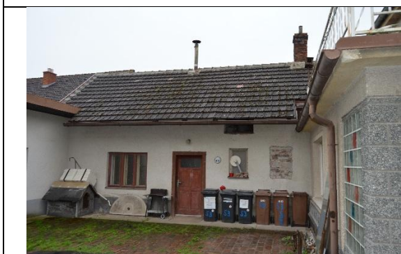
POHLED ZE DVORA PŘÍZEMNÍ ČÁST
