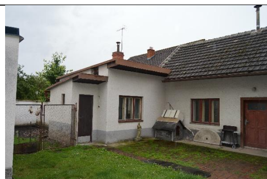
POHLED ZE DVORA PŘÍZEMNÍ ČÁST
