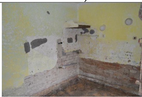
PŘÍZEMNÍ ČÁST V REKONSTRUKCI
