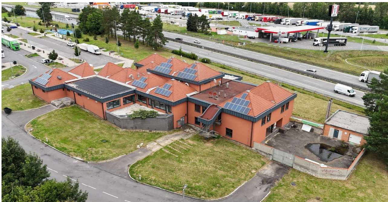
Pohled na objekt občanské vybavenosti č.p. 56 v obci Trhový Štěpánov, místní části Střechov nad Sázavou.
