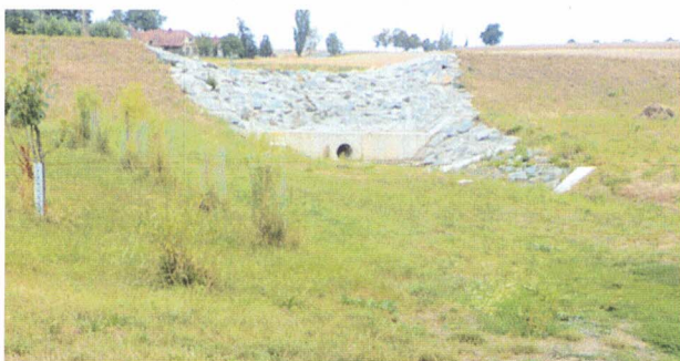
Hráz poldru realizovaná na části pozemku parcelní číslo 43/2
