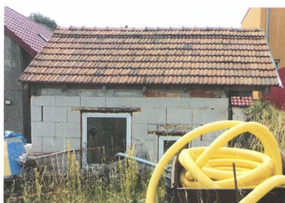
rozestavěný přístřešek – severní strana;
