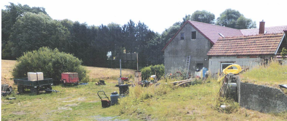
Kolem objektu na posuzovaných pozemcích je značné množství odpadu.
