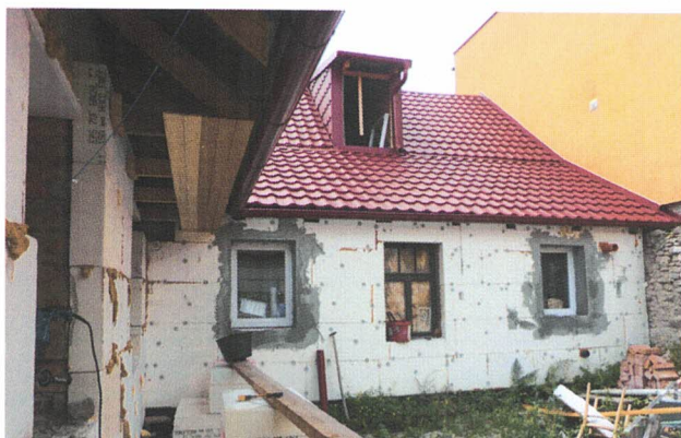
Severní průčelí jižního traktu stavby ř.p. 29, k.ú. Březsko;
