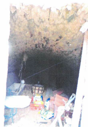
Sklep pod částí domu
