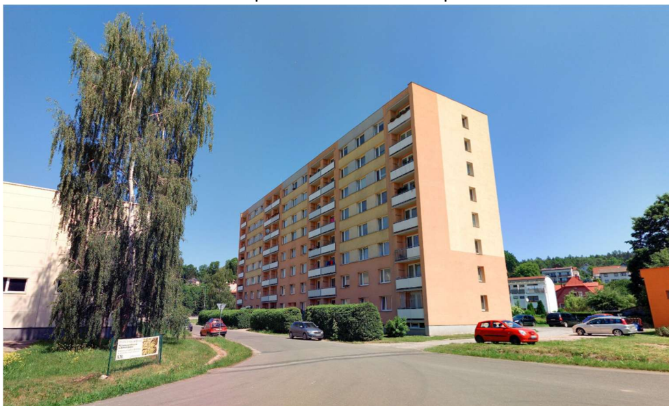
Pohled na bytový dům čp. 762,763 a 764
